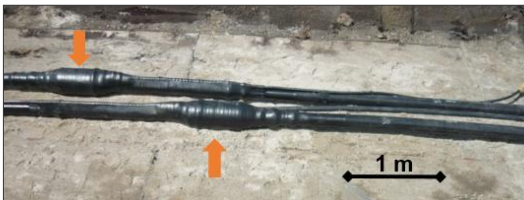
Abbildung 7: Muffen (Pfeilmarkierung) vor Wiederverfüllung des Leitungsgrabens 7
